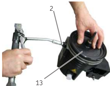
Рис. 16. Заполнение пространства под емкостью
